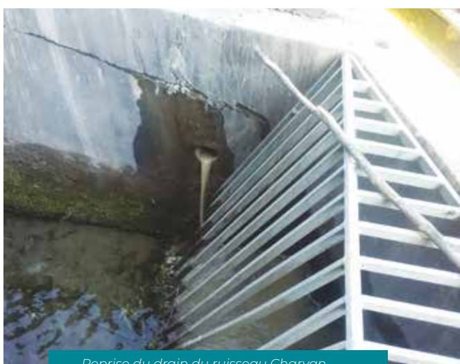
Reprise du drain du ruisseau Charvan
