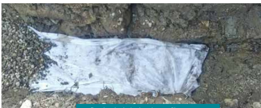
Reprise du drain du ruisseau Charvan
