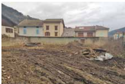
L'espace de la Fontaine au démarrage des travaux et en septembre 2022.
