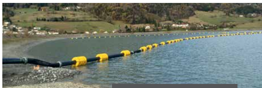
La conduite de refoulement (en noir) et les flotteurs (en jaune)
