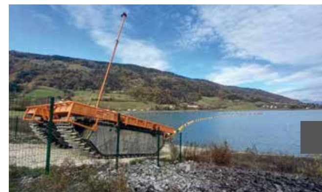
Le robot @SUPER NESSIE prêt à plonger dans les eaux du bassin du Flumet
