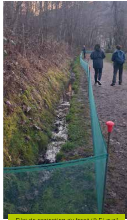
Filet de protection du fossé (© F.Laval)
