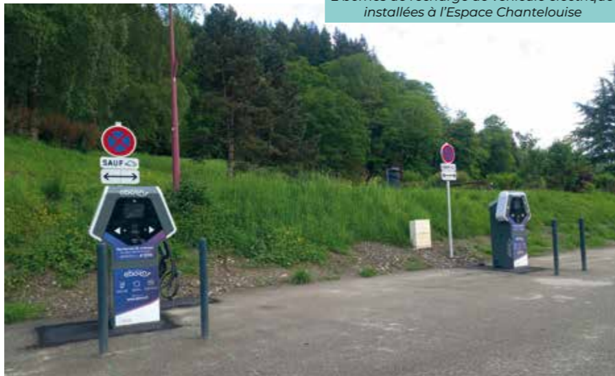
2 bornes de recharge de véhicule électrique installées à l'Espace Chantelouise
